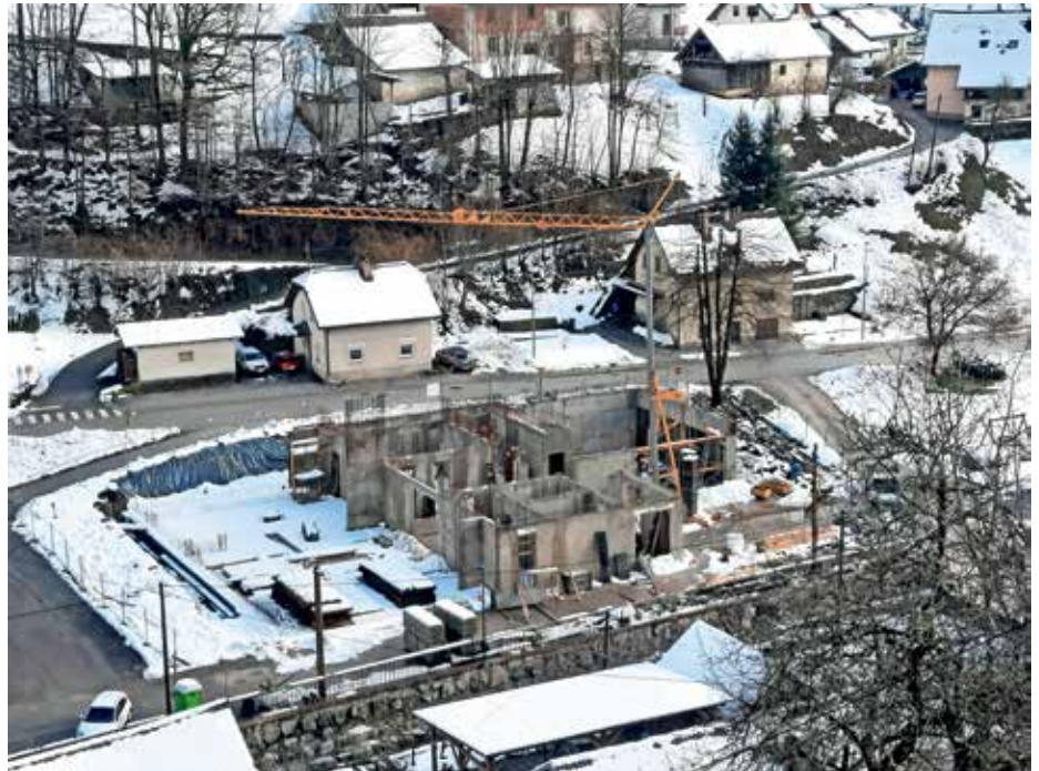
Gradnja novega kulturnega doma v Poljanah FOTO: ARHIV KS
